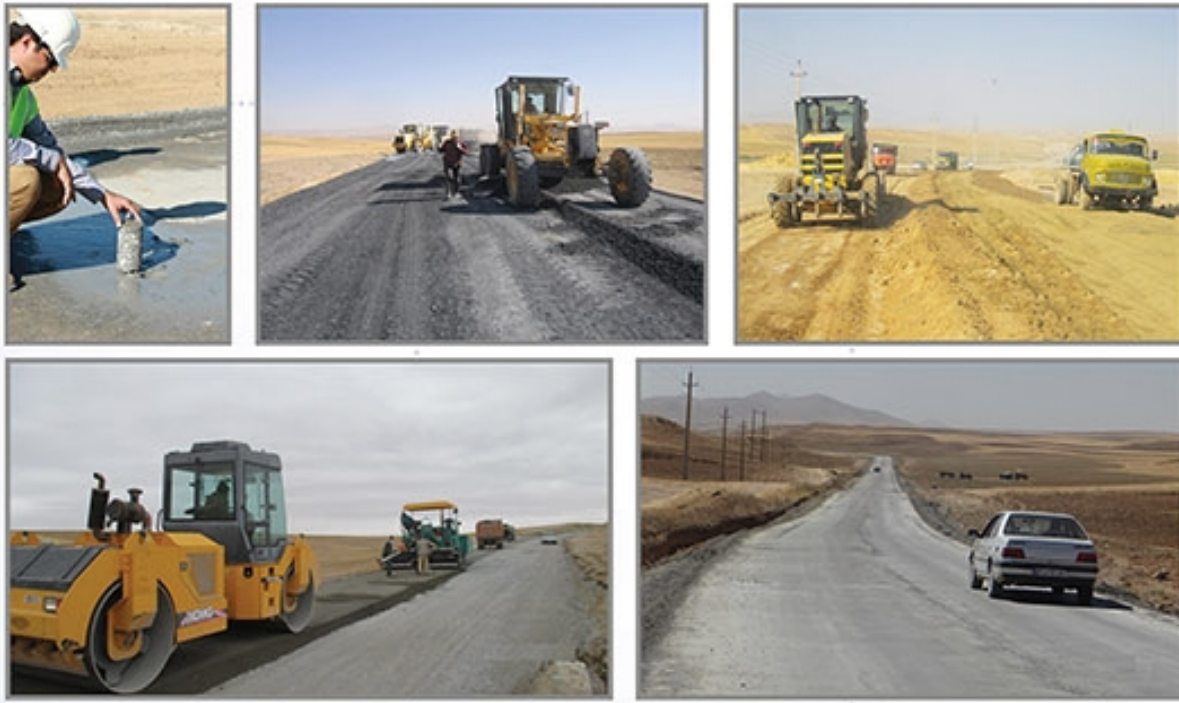
احداث راه دسترسی به معادن احمدآباد باش
